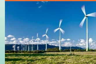
Geração Eólica e Solar
