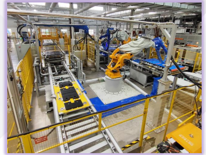
Linha - Packs de Baterias Blade. Ônibus elétrico
